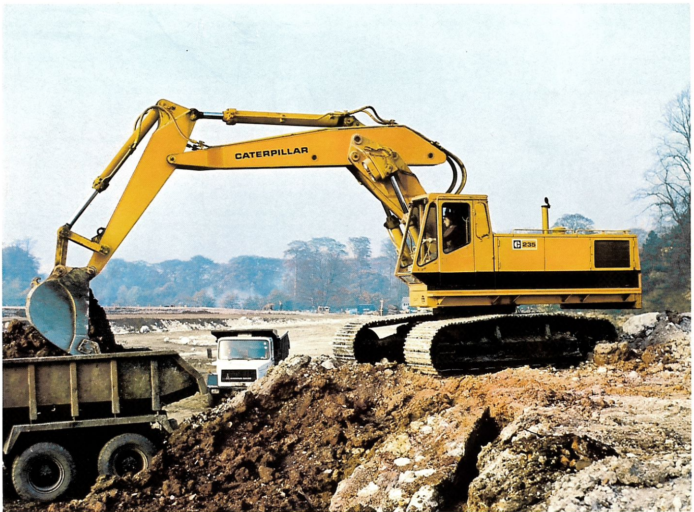
Excavadora 235 con pluma de corredera.
